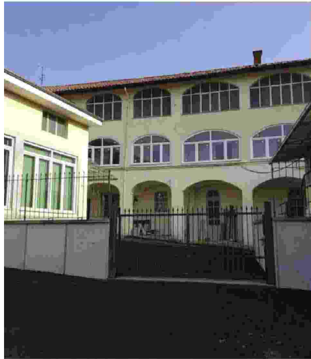
L'ex Casa delle suore di frazione Doccio, ristrutturata per ospitare Centro Alzheimer e appartamenti di residenza sociale
